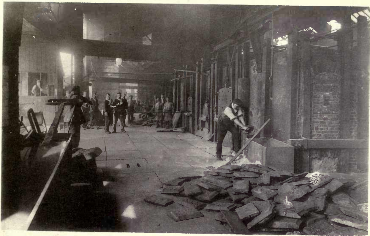
SIEMENS-MARTIN FURNACES, 1 45 TON., 2 30 TON..
